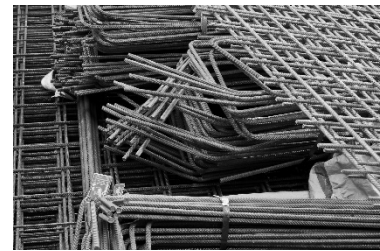
Abb. 1: Bewehrungsstahl vor dem Einbau [4]
